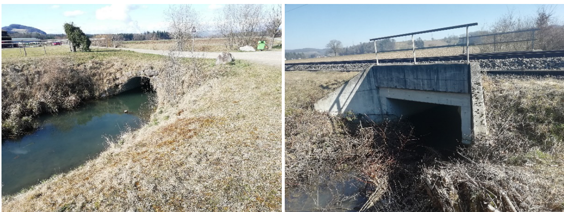
Fig. B-4: Durchlass Unterbodenweg (links) und Durchlass Bahndamm (rechts)
