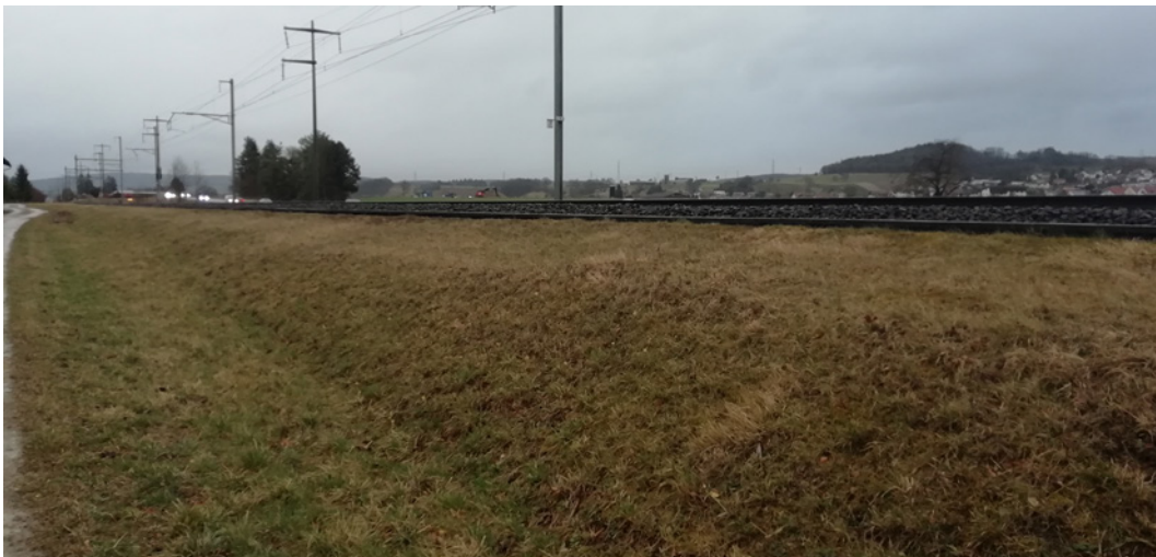
Fig. B-5: Strassen- und Eisenbahndamm
