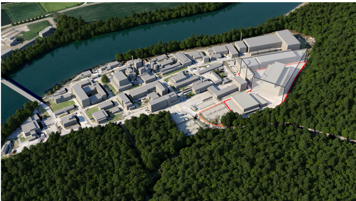
Fig. 4-3: Vogelperspektive des Industrieareals (Blickrichtung Nordwest) mit Anlagenperimeter (rot umrandet) und Installationsfläche (orange umrandet)
