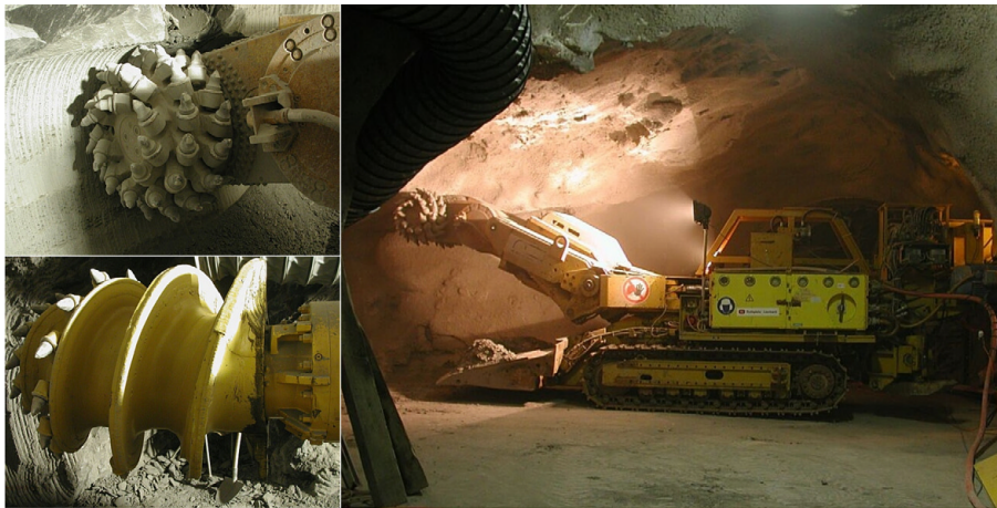
Fig. 4.3 Teilschnittmaschine mit Längs- und Querschneidkopf wie sie z.B. im Opalinuston des Felslabors Mont Terri eingesetzt wurde
