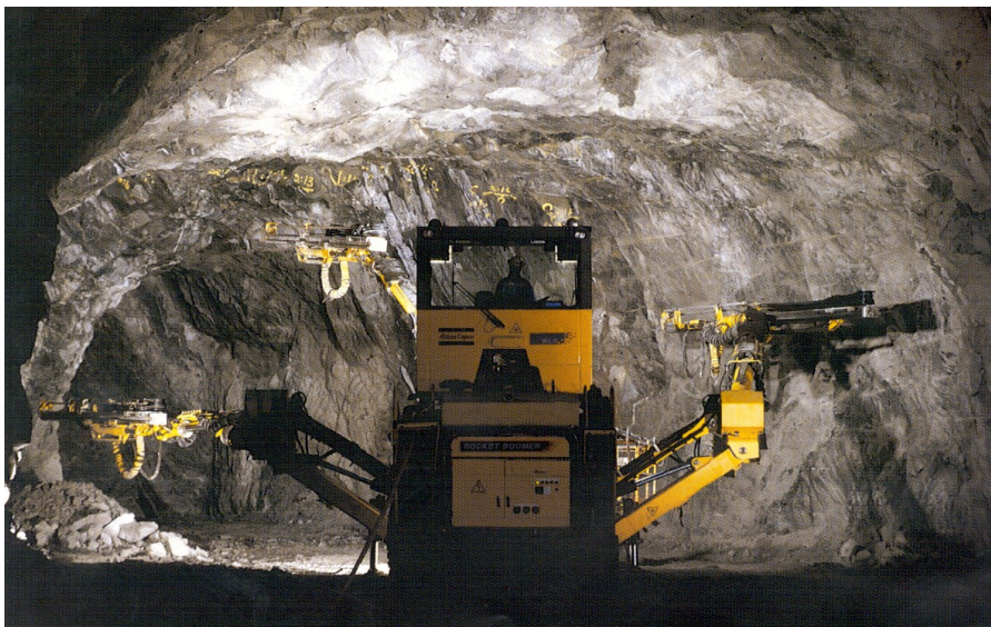
Fig. 4.4 Bohrjumbo zum Bohren der Löcher im Sprengvortrieb
